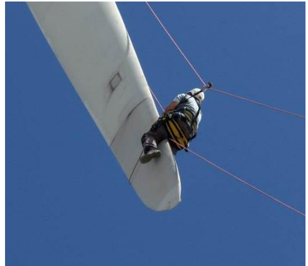
Figure 17 : Inspection d'une pale sur le parc éolien d'Avignonet-Lauragais (Haute-Garonne) Source : Boralex
