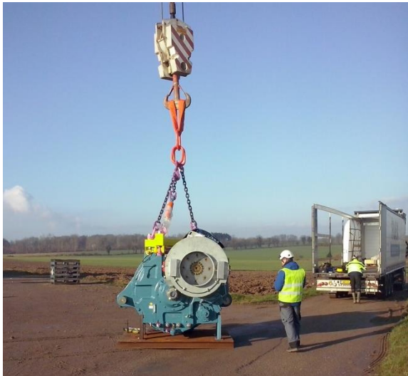
Figure 16 : Changement d'un multiplicateur sur le parc éolien d'Hermin (Pas-de-Calais) Source : Boralex
